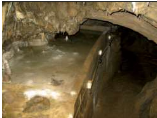
Abb. 9: Neues Olmenzuchtbecken; Foto Michael K. Brust
